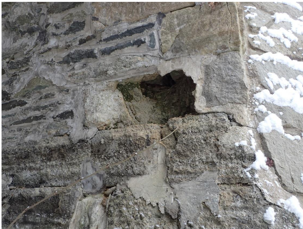
Foto 3: Místy vypadané kameny, popraskané spárování
