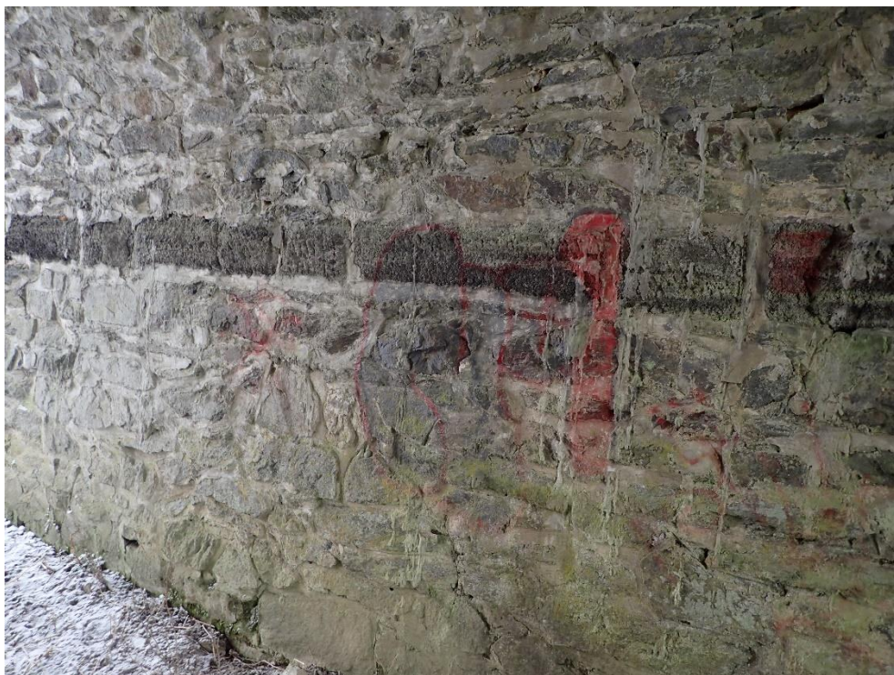
Foto 4: Vypadané spárování, průsaky skrz zdivo, výkvěty, vandalismus
